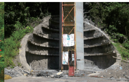
竹削工法於橋墩施作
